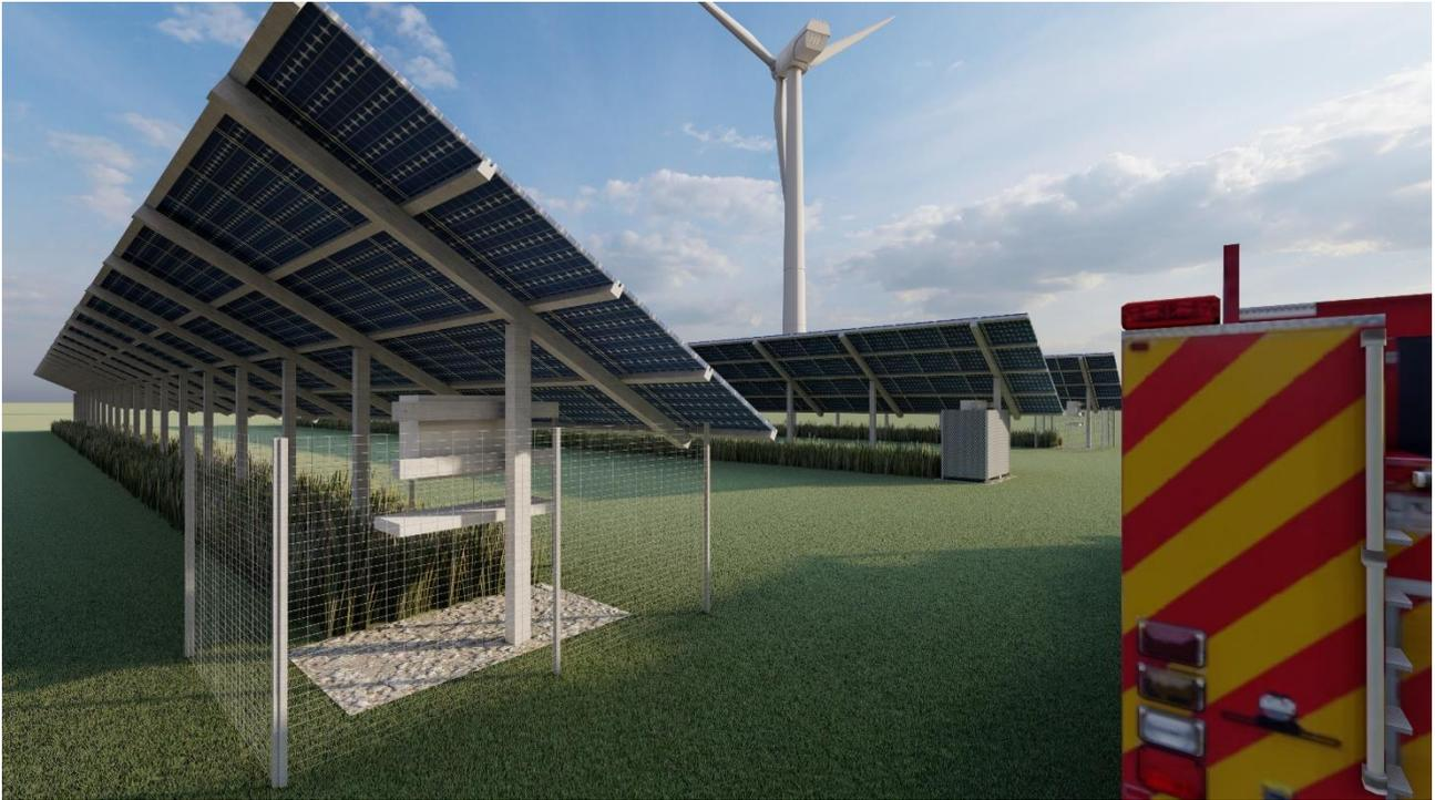
Abbildung 4 – Anordnung der Wechselrichter im Bereich der Fahrwege
