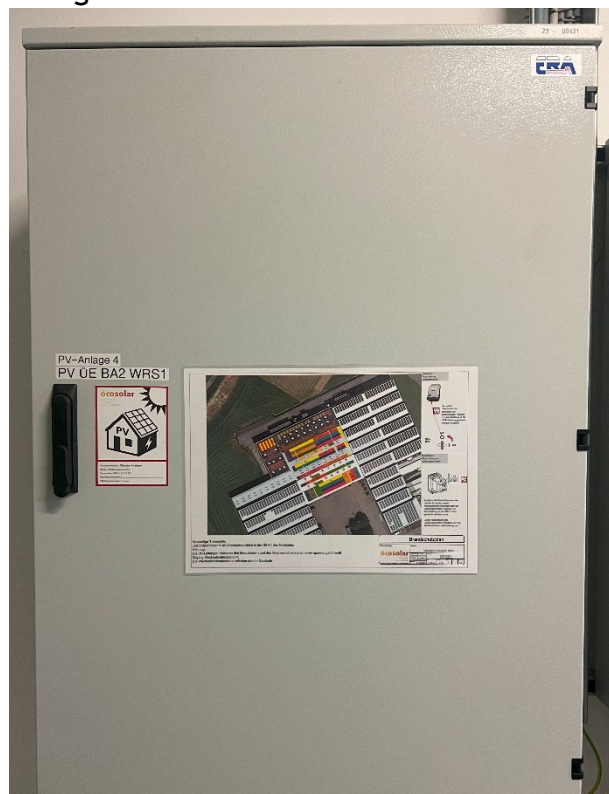
Abbildung 20: Entkupplungsstelle (Springer)
