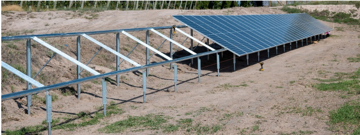
Abbildung 16: Montagevorbereitung für „stehende“ PV-Module (user20014964 - freepik.com)
