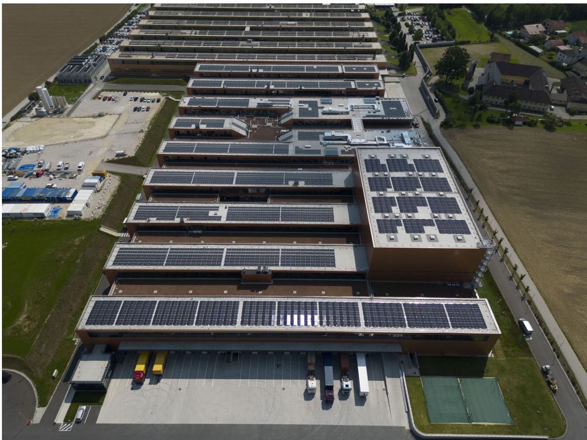
Abbildung 6: PV-Anlage auf Industrieobjekten (Fronius)
