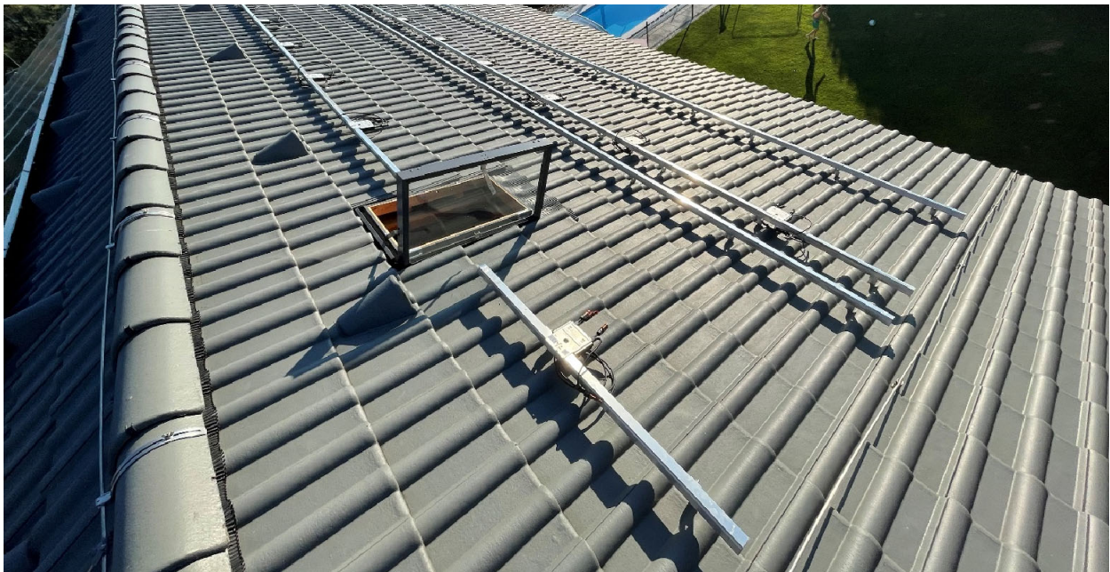
Abbildung 15: Montagevorbereitung einer PV-Anlage auf einem Pultdach (EyeEm - freepik.com)
