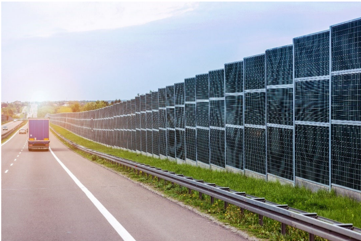
Abbildung 8: PV-Lärmschutzwand (maryanaserdynska - freepik.com)
