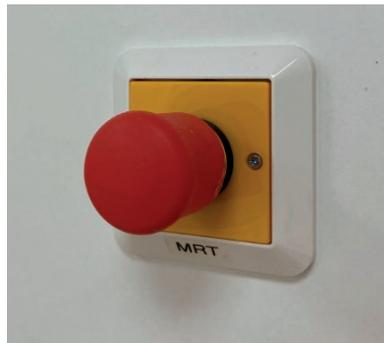
Abbildung 23: Not austaster für die Trennung der Stromversorgung
