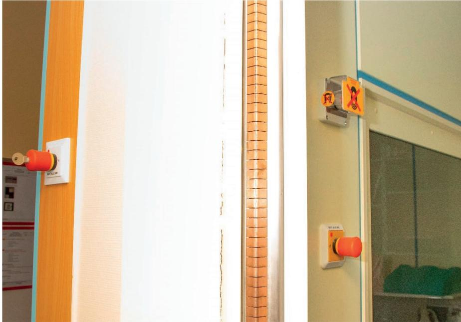
Abbildung 16: Quenchtaster und elektrischer Not-Aus-Taster direkt bei Eingang zum Untersuchungsraum
