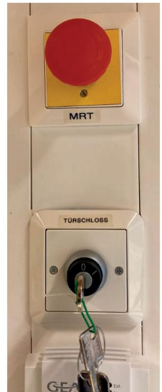
Abbildung 25: Beispielbild für Verriegelung der Kabinentüre in Kombination mit Not-austaster für die Trennung der Stromversorgung
