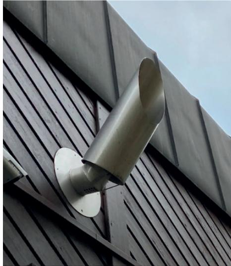
Abbildung 12: Beispiel für ein Quenchrohr / Ablassrohr
