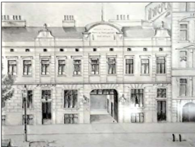
Abb. 2. Filialsanitätsstation am Mariahilfer Gürtel
